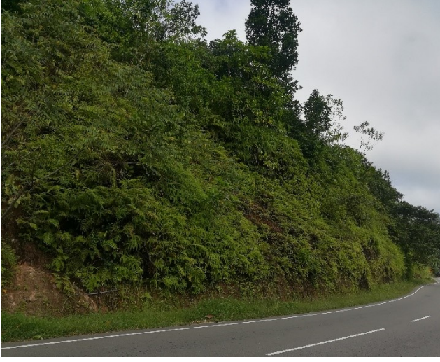
உரு 05 (அ) - வீதி கட்டுமானத்திற்கான பொருத்தமற்ற செங்குத்து வெட்டின் விளைவாக மாற்றப்பட்டுள்ள இயற்கை சாய்வு பகுதி
